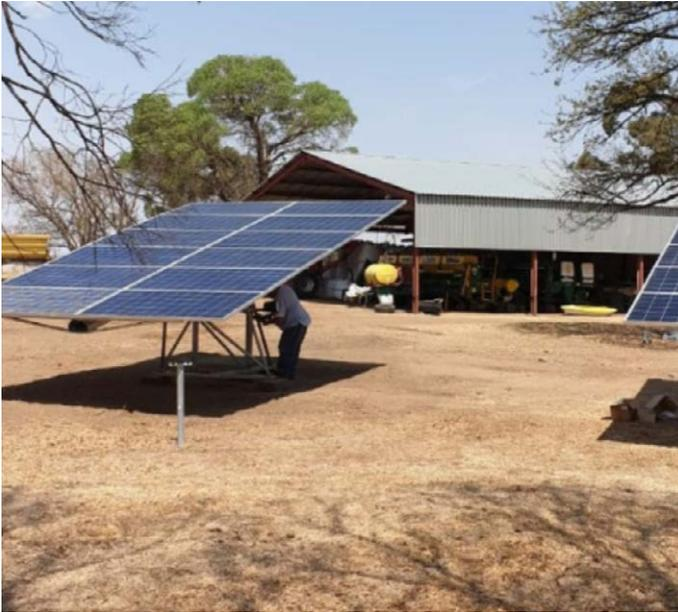
Les trackers solaires sont des **dispositifs** qui permettent aux panneaux solaires de **suivre la trajectoire du soleil** dans le ciel **tout au long de la journée**. En d'autres termes, les trackers solaires ajustent automatiquement **l'orientation** des panneaux solaires pour maximiser l'exposition aux rayons du soleil, ce qui peut augmenter considérablement la production d'énergie solaire.
